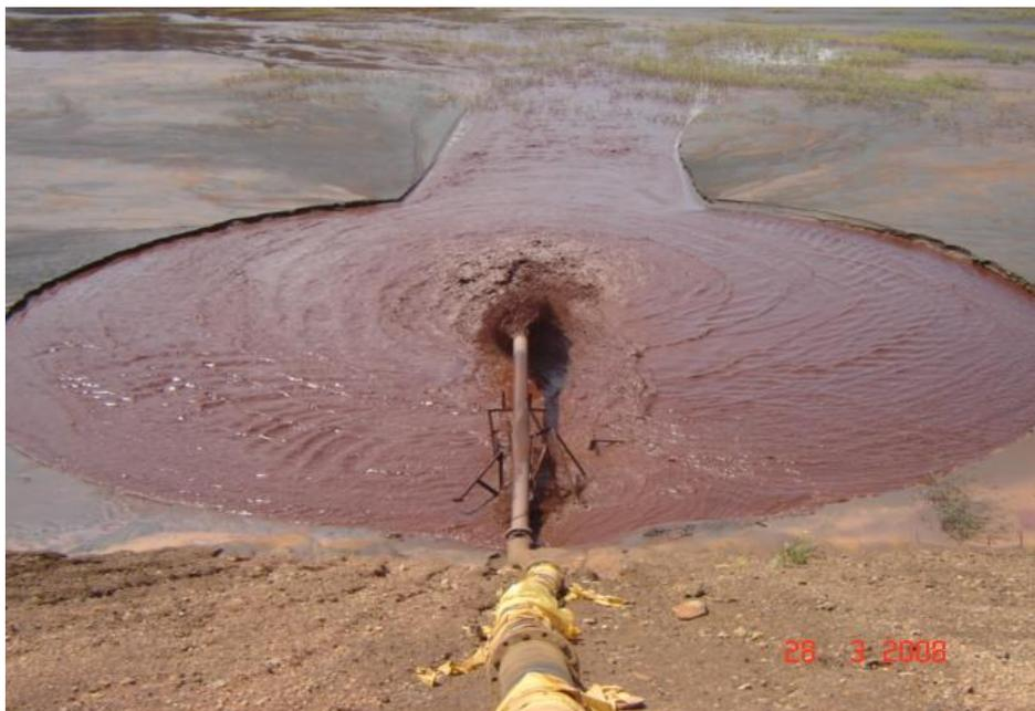
Figura 3.7 – Disposição de rejeitos pela técnica de espigotamento
